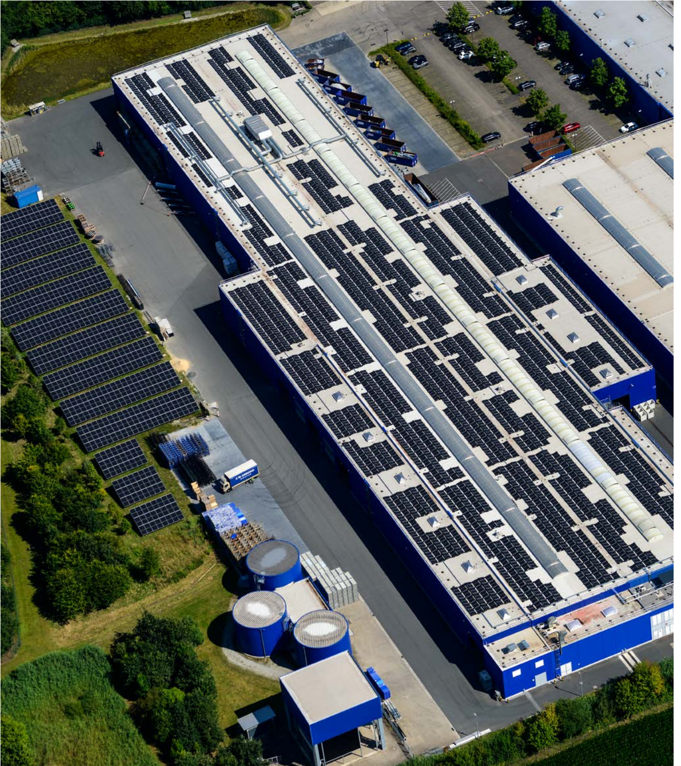
设置在霍曼厂房屋顶的光伏系统，是绿色电力的来源之一。
